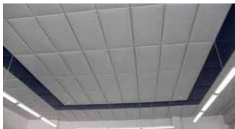
ПОТОЛОК В ПРОИЗВОДСТВЕННОМ ПОМЕЩЕНИИ
